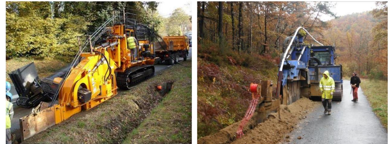
Figure 7: Trancheuse et exemple de pose de câble à la trancheuse
